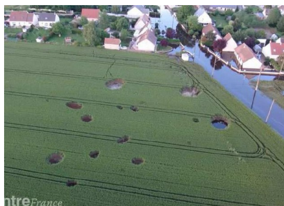
Figure 10 - Effondrements à Gidy (source La République du Centre)
